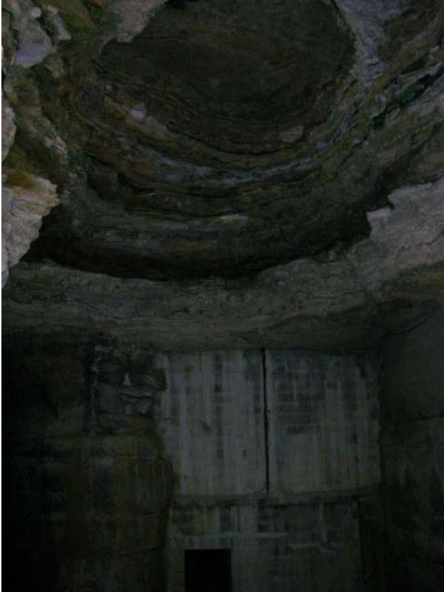
Photo 2 : Exemple d'une cloche de fontis situé dans une des carrières de Conflans.
